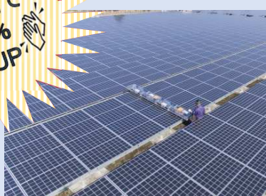
専用機器によるパネル洗浄
